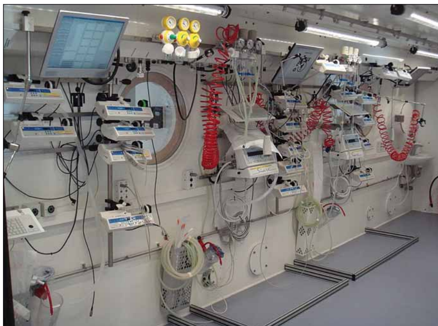
Obr. 1. Vybavení hyperbarické komory certifikovanou zdravotnickou technikou pro ošetření pacientů v režimu intenzivní péče – Univerzitní nemocnice v Lille [5].
